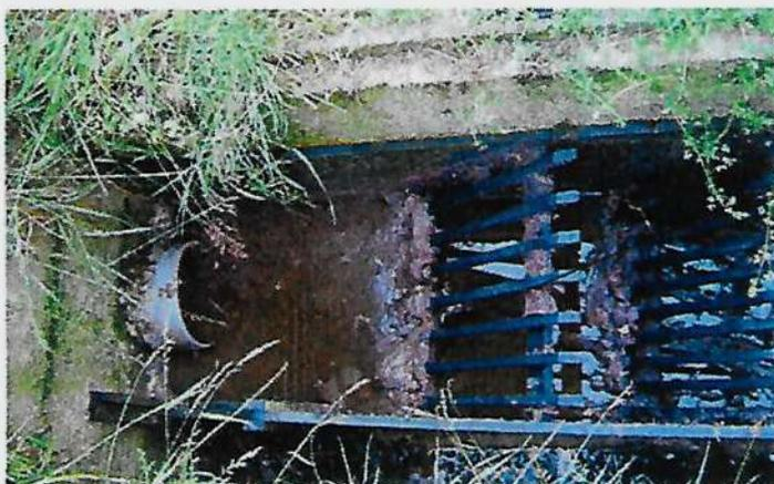
Exemple de **déchets indésirables** rejetés dans une station et **obstruant** le dégrilleur
