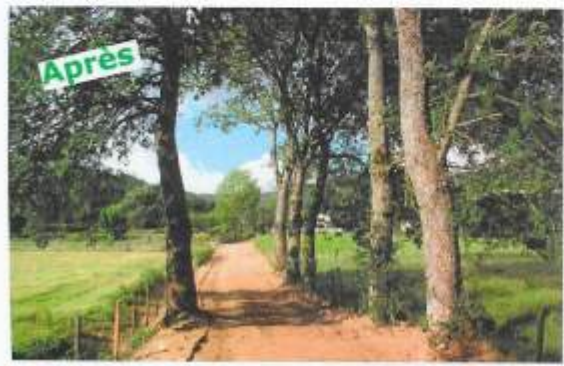
Job - Voirie communale après travaux
