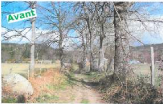
Job - Voirie communale avant travaux
